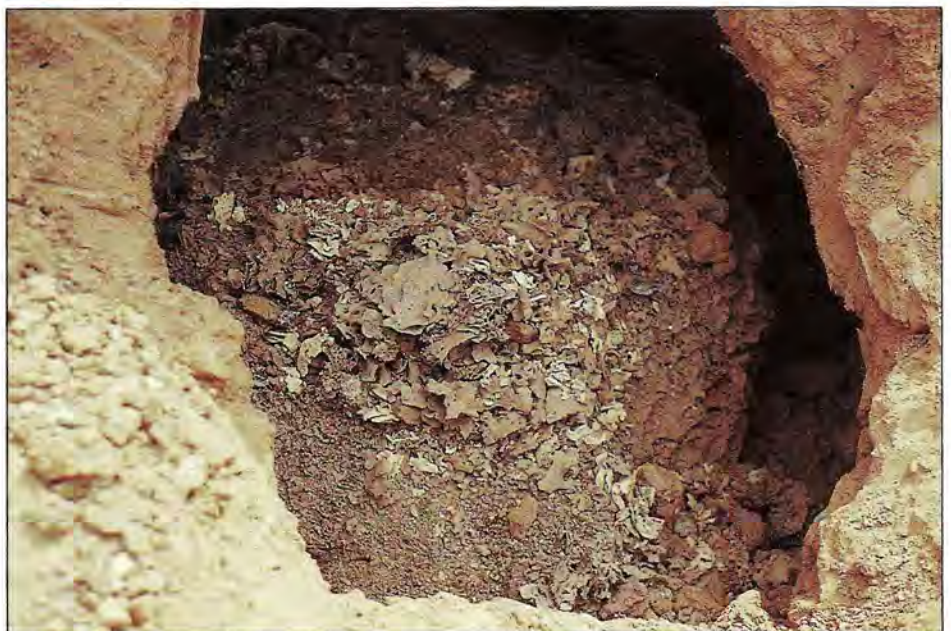
Habitacle dégradé. (Cliché C. Girard).
